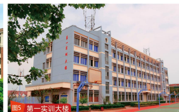
图5 第一实训大楼
